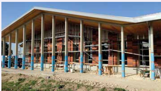
La façade en travaux
