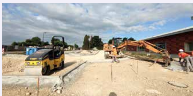
Réalisation du parking
